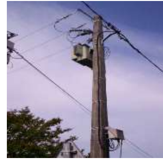
Les postes de transformation de moyenne tension en basse tension
