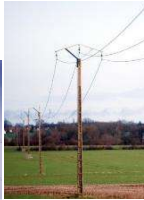
Les réseaux HTA aériens (moyenne tension)
