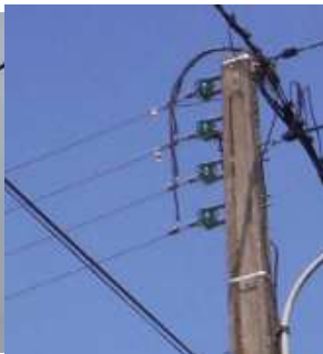
Les réseaux basse tension
